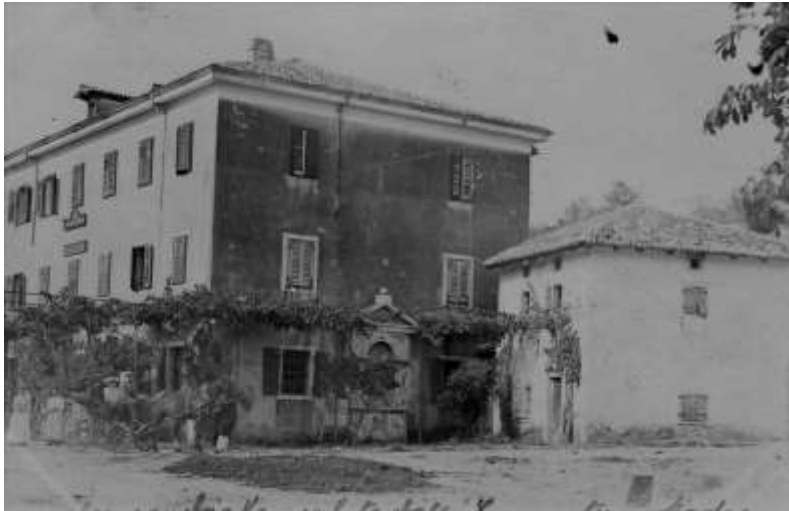
Stavba gostilne Ličen pred letom 1900
